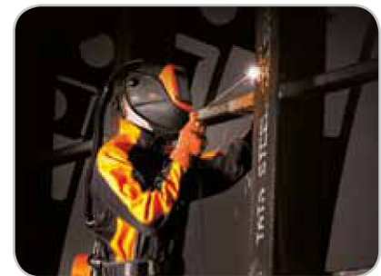
Bouw en lassen op locatie onder zware omstandigheden
